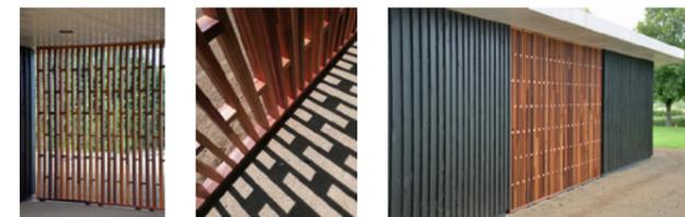
Les claustras sont livrés par modules de 1m x H 2,9m, et sont rapides à assembler sur site. Les montants de 40 par 100 mm sont assemblés sur des lisses horizontales. La lisse basse présente des pentes pour l'écoulement de l'eau, elle est posée sur des plots en EPDM.
