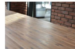
Le dessin de nouvelles formes ainsi que leurs assemblages, ici 5 panneaux en lamellé-collé de pièces de bois massif permettent d'offrir une deuxième vie inventive et qualitative à ce matériau, actuellement destiné au rebut.
