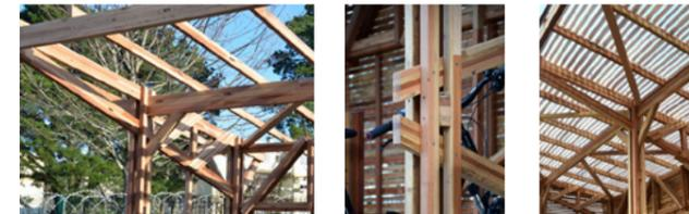
Nous avons travaillé la charpente comme un assemblage 3D de pièces de faibles sections. L'optimisation donnée des sections des pièces, avec l'aide de Vivier Structure Bois, nous a permis d'obtenir ce dessin léger. Couverture en polycarbonate alvéolaire.
