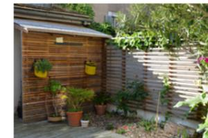
Un abri complète l'aménagement : les portiques structurant cette micro-architecture sont également réalisés en lamellé-vissé, et un lattis de faible section, cloué, constitue l'enveloppe et participe à la stabilité du volume. Ce projet est pour nous une première occasion de fabriquer des ossatures porteuses en bois issu de réemploi.
