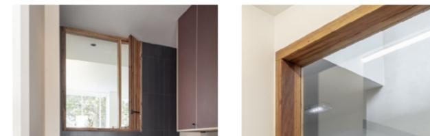
Les châssis **CFe01** soulignent la rencontre de ces essences par le traitement huilé de la surface. Les parclozes sont également issues de bois surcyclé. Leur fixation est faite par vis, de manière à faciliter leur démantèlement en fin de vie.
