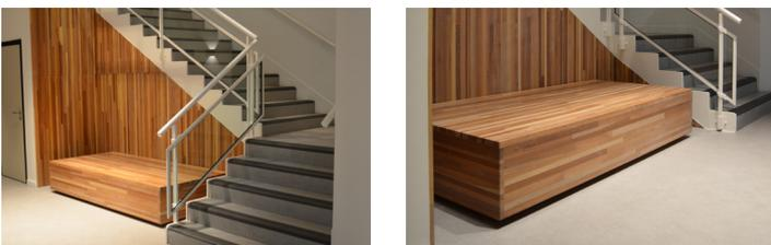
Le dessin de nouvelles formes ainsi que leurs assemblages, ici 5 panneaux en lamellé-collé de pièces de bois massif permettent d'offrir une deuxième vie inventive et qualitative à ce matériau, actuellement destiné au rebut.
