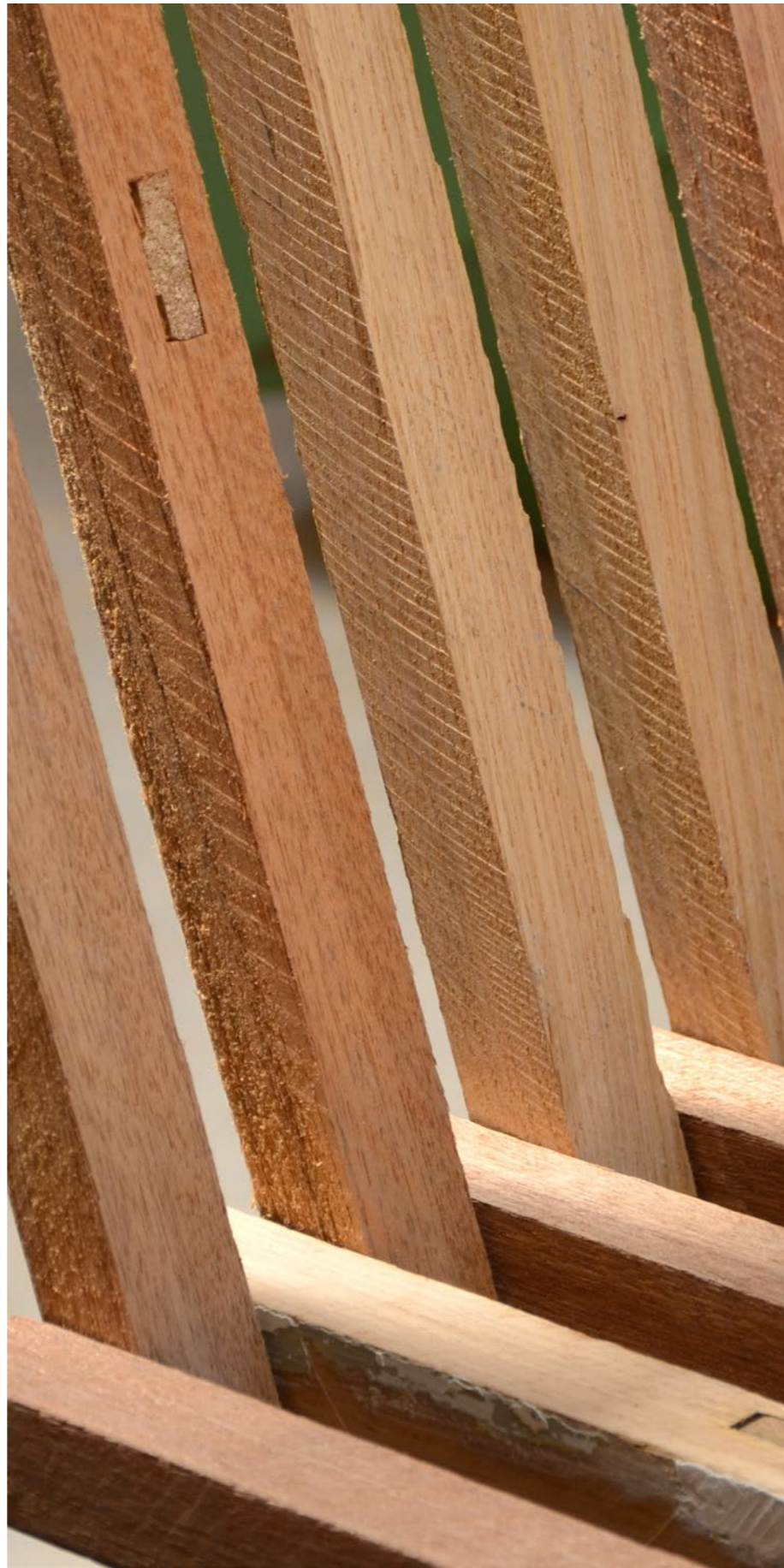
Pièces entretoisées, épaisseurs entre 27 et 32mm
