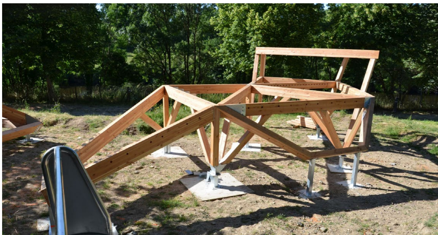
Photo de chantier - Crédit photo @100 Détours
