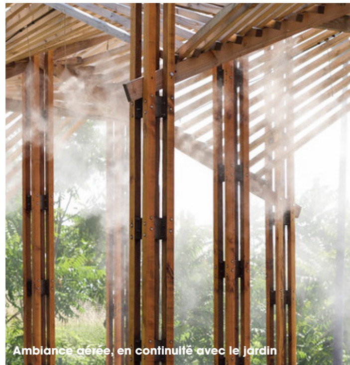
Le toit est recouvert de lattes de bois
