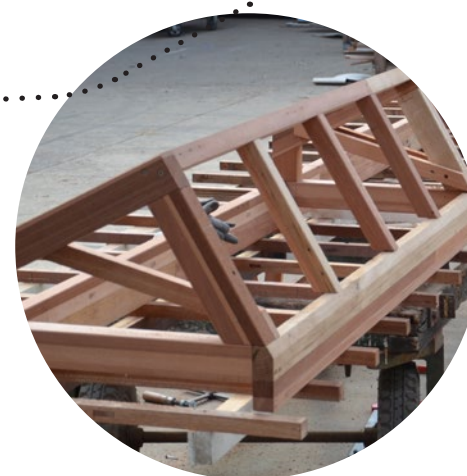
Assemblage des ossatures à l'atelier
