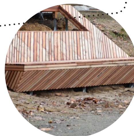
Installation sur site
