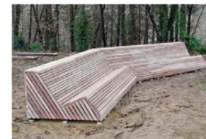
Ce projet est l'occasion pour nous de fabriquer pour la première fois une structure porteuse en lamell-collé surcyclé. Les éléments ont été préfabriqués dans nos ateliers, puis transportés et assemblés sur place par tronçons.
