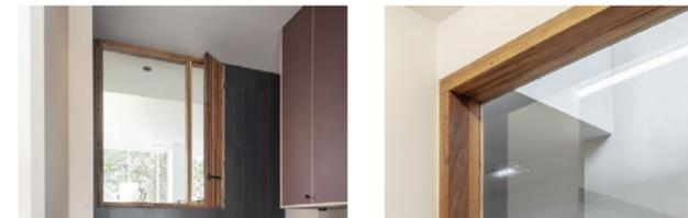
Les châssis CFe01 soulignent la rencontre de ces essences par le traitement huilé de la surface. Les parclozes sont également issues de bois surcyclé. Leur fixation est faite par vis, de manière à faciliter leur démontage en fin de vie.
