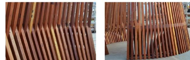
L'ensemble du bois qui compose le Tipi (y compris les ceintures et les contre-plaqués) sont des bois de réutilisation d'anciennes menuiseries extérieures. Il est ici installé dans la médiathèque du lac, à Châtellerault. Sa fabrication par modules permet une installation par 2 personnes.
