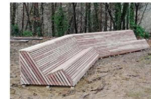
Ce projet est l'occasion pour nous de fabriquer pour la première fois une structure porteuse en lamellé-collé surcyclé. Les éléments ont été préfabriqués dans nos ateliers, puis transportés et assemblés sur place par tronçons.
