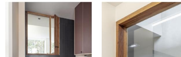
Les châssis CFe01 soulignent la rencontre de ces essences par le traitement huilé de la surface. Les parclozes sont également issues de bois surcyclé. Leur fixation est faite par vis, de manière à faciliter leur démontement en fin de vie.
