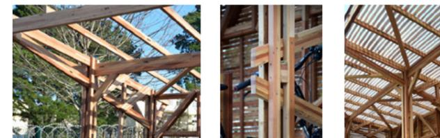
Nous avons travaillé la charpente comme un assemblage 3D de pièces de faibles sections. L'optimisation donnée des sections des pièces, avec l'aide de Vivier Structure Bois, nous a permis d'obtenir ce dessin léger.
