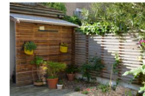
Un abris complète l'aménagement : les portiques structurant cette micro-architecture sont également réalisés en lamellé-vissés, et un lattis de faible section, cloué, constitue l'enveloppe et participe à la stabilité du volume. Ce projet est pour nous une première occasion de fabriquer des ossatures porteuses en bois issu de réemploi.
