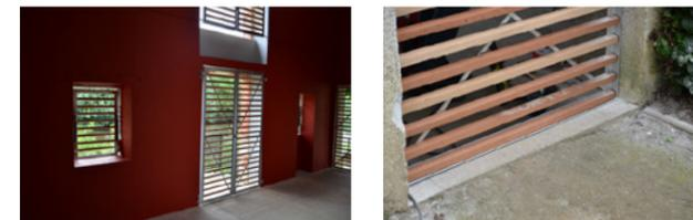
Le bâtiment de «la tomate» est fermé par sept volets persiennés : un dispositif simple de ventelles sur cadre acier galvanisé. Les volets sont placés au nu intérieur de la façade, afin de conserver la lecture des ouvertures et les protéger contre les intempéries.
