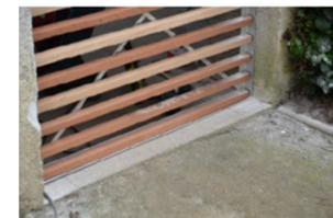
Le bâtiment de «la tomate» est fermé par sept volets persiennés : un dispositif simple de ventelles sur cadre acier galvanisé. Les volets sont placés au nu intérieur de la façade, afin de conserver la lecture des ouvertures et les protéger contre les intempéries.
